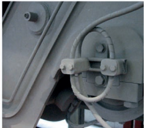
Situation corrigée: nouvelle position du câble
