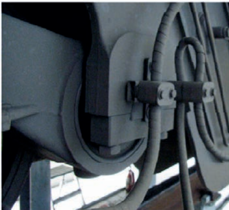
Situation initiale: le câble posé par l'usine
