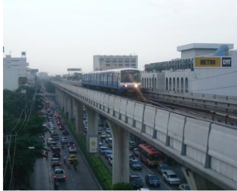
Abb. 6-2: Das Trasse des Skytrains verläuft komplett auf Viadukten hoch über dem Grund [19].
