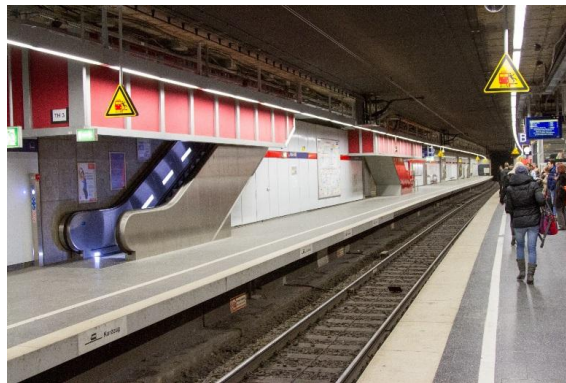
Abb. 6-5: Der Aussenbahnsteig (links) und der Mittelbahnsteig (rechts) bei der S-Bahn-Station Hauptbahnhof erlauben einen schnellen Fahrgastwechsel.
